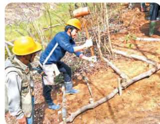
伐採した樹木を加工して階段づくり中
