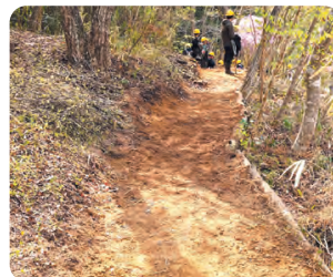
立派な歩道が完成しました
