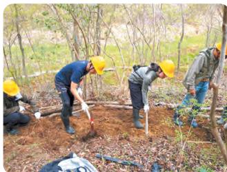
山側の土を削り、谷側にその土を盛り歩道を整備中
