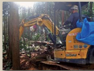
斜面への影響の少ない路網を作るために、小型の作業機械を使って地形の凹凸に合わせて路網の形を作ります。立木も必要以上には伐らず、道際ギリギリまで残します。
