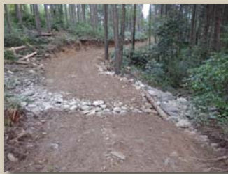
現地の石や木を利用した、横断排水施設。大雨で路網や斜面が崩れないよう、路網整備には水のコントロールが大切です。普段は水がなくても、大雨の時に水が集まりやすい場所には排水施設を作っておきます。
